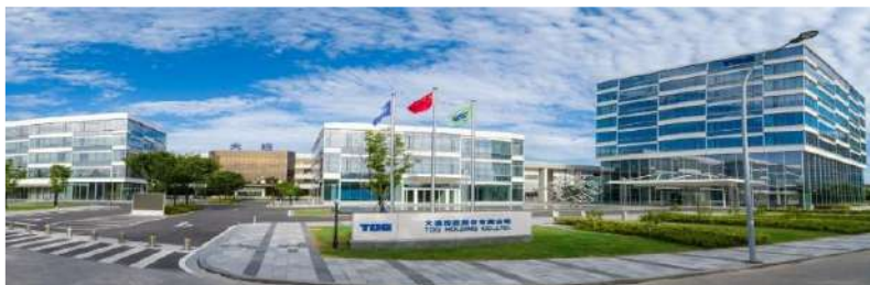
运营管理总部 Operations Headquarters
