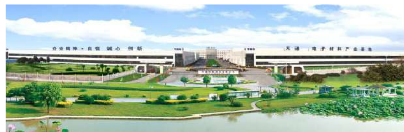
电子材料核心基地 (磁体、晶体材料) Electronic Components Base
