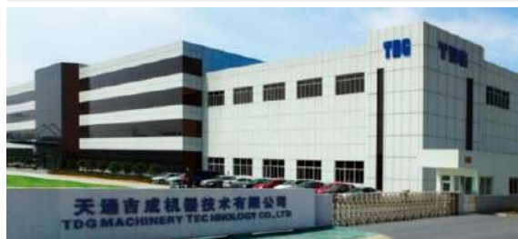
智能装备核心基地 Intelligent Equipment Base
